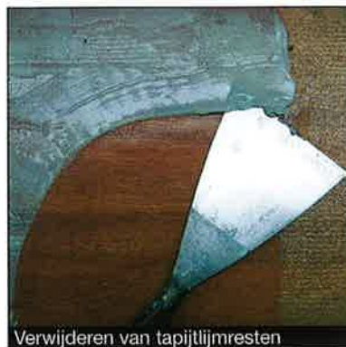
Verwijderen van tapijtlijmresten
